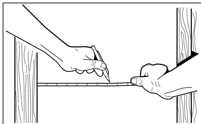
4. Desde el interior del ático, encuentre la ubicación deseada para el ventilador y marque un punto a la mitad entre las vigas, que se encuentre de 24 a 36 pulg. (61 a 91 cm) debajo del saliente del techo.
